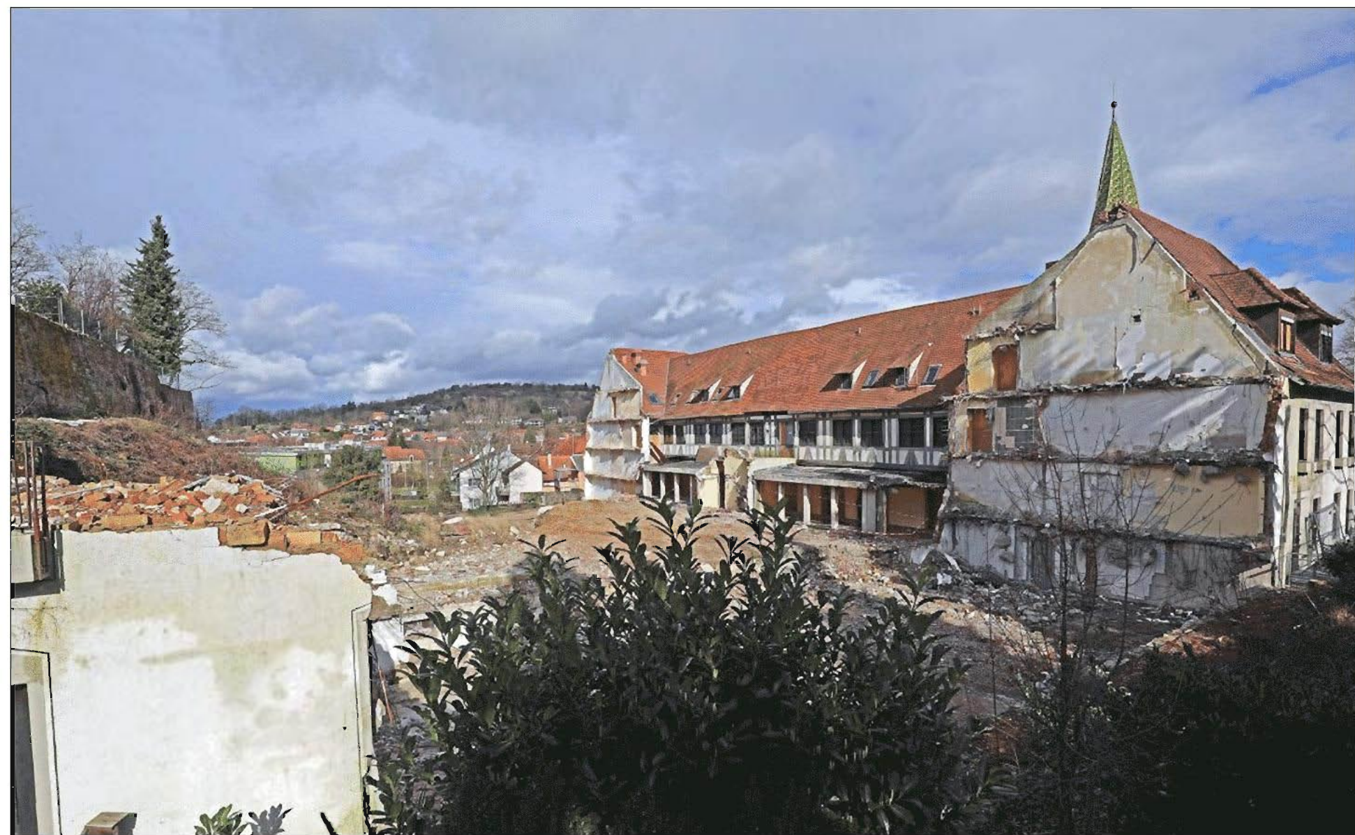
DER BAUPLATZ an der Rückfront des Grötzinger Schlosses ist schon lange weitgehend frei geräumt. Die Seitenflügel sind abgerissen. Doch die Arbeiten gehen seit vielen Monaten überhaupt nicht mehr voran. Nicht alle Fragen zur Statik der Mauer (links), die den Augustenberg hang stützt, sind geklärt. Fotos: jodo
