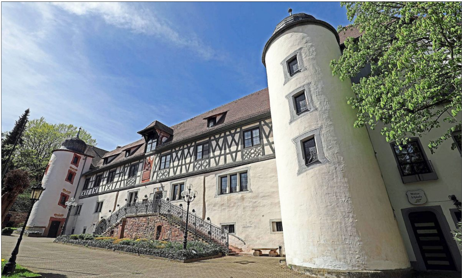
PRÄGEND FÜR GRÖTZINGEN ist die Anlage des Schloss Augustenburg. Die Umbaupläne sehen die Sanierung und den Ausbau für ein Pflegezentrum vor, der historische Mittelteil und die beiden Türme sollen erhalten werden. Die beiden Außenflügel werden abgerissen und neugebaut, hinzu kommt ein Nordbau. Archivbild: jodo
